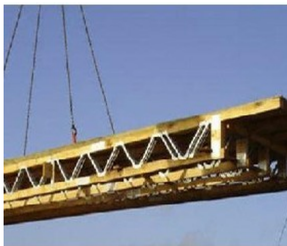
Planseu cu zabrele tip Posi Floor
