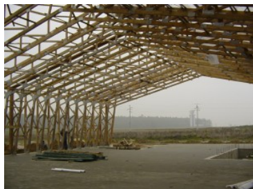
Hale din lemn cu ferme tip portal-cadre din grinzi cu zăbrele din lemn
