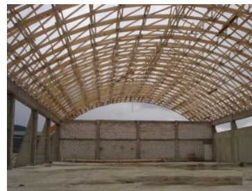
Hale din lemn și depozite din lemn cu ferme din lemn tip arc de cerc
