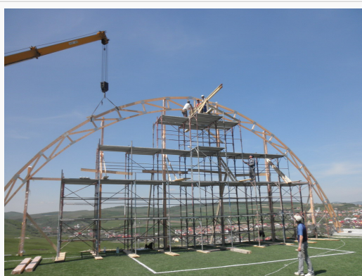
Acoperis din lemn teren de fotbal
