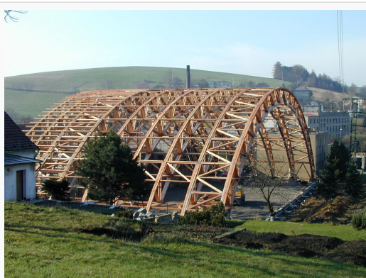
Acoperis din lemn sala de sport
