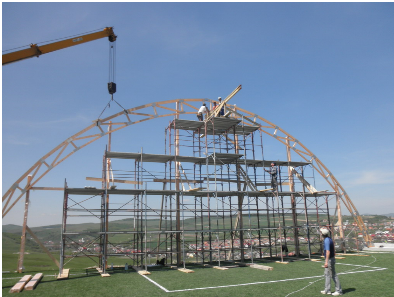
Acoperis din lemn teren de fotbal
