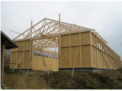
Hale din lemn cu pereti integrali din lemn (framing)
