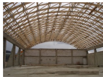
Hale din lemn si depozite din lemn cu ferme din lemn tip arc de cerc
