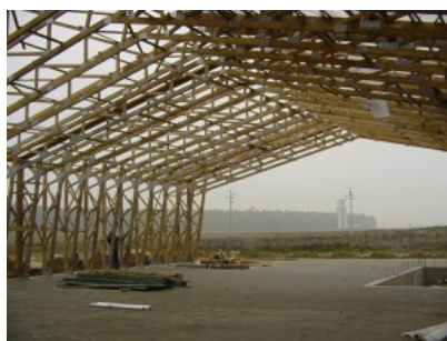
Hale din lemn cu ferme tip portal- cadre din grinzi cu zabrele din lemn
