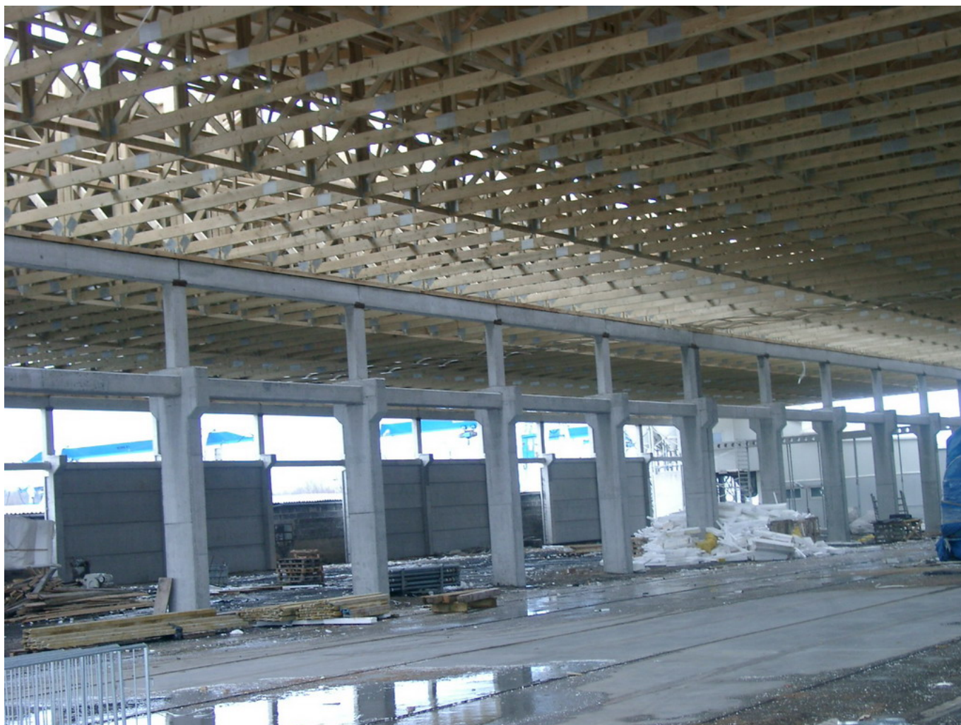
Hala cu stalpi de beton si sarpanta din lemn
