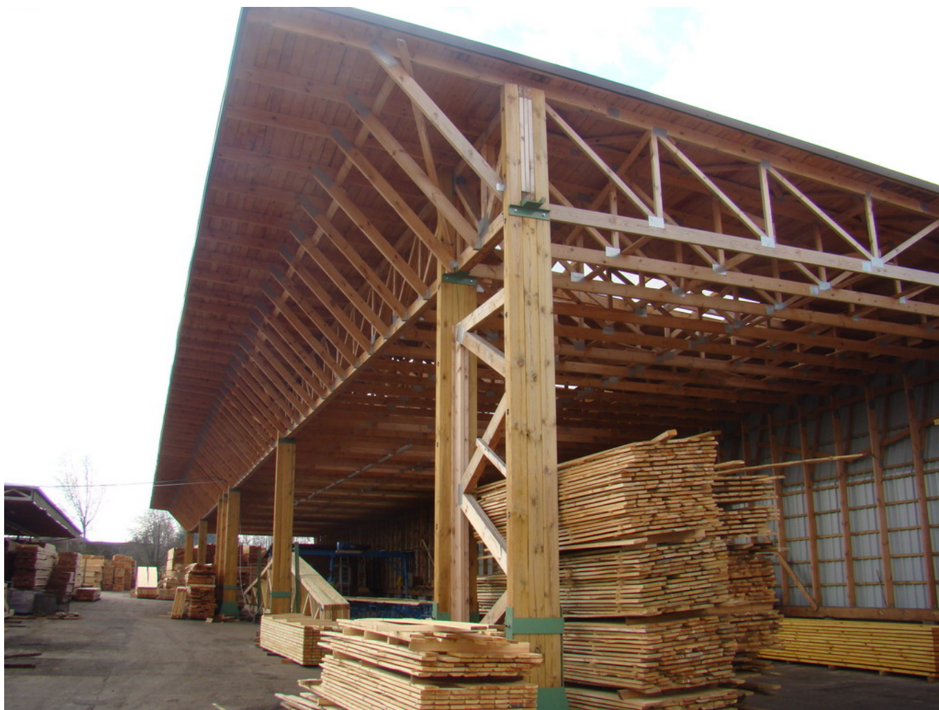
Hala din lemn – Fabrica de sarpante
