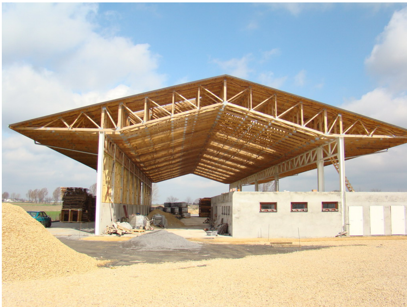
Hala pe structura metalica si sarpanta din lemn
