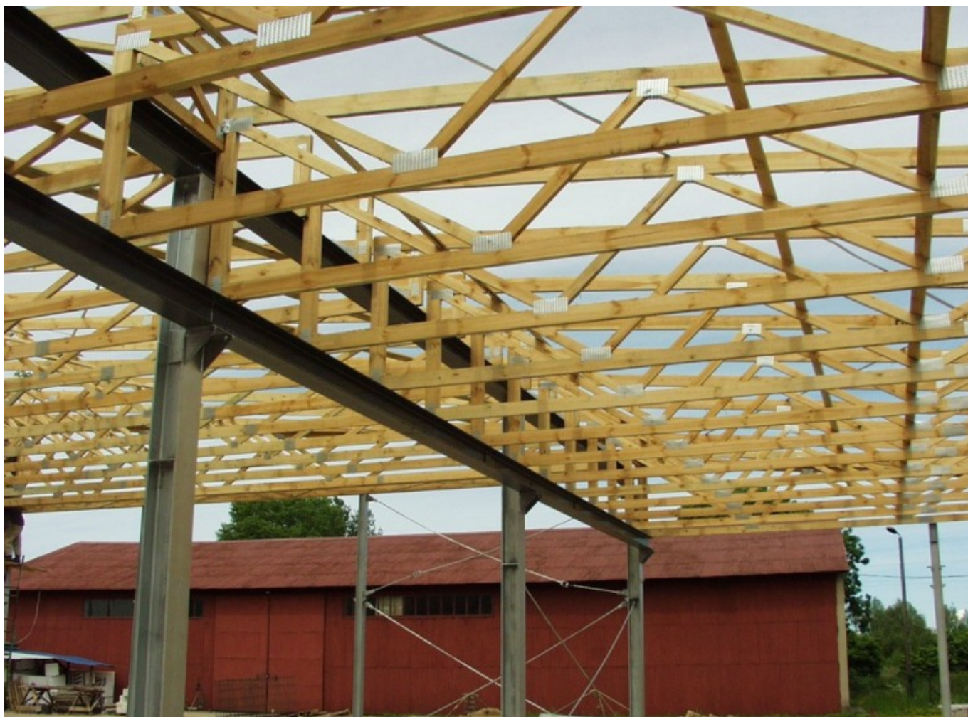
Hala metalica cu sarpanta din lemn
