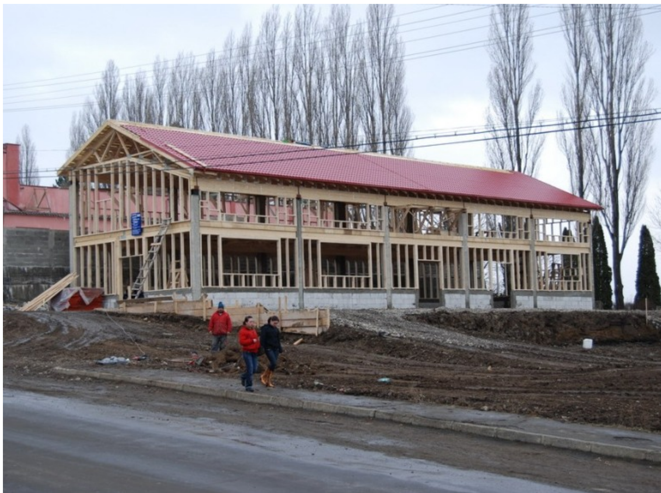
Amenajare depozit Falticeni
