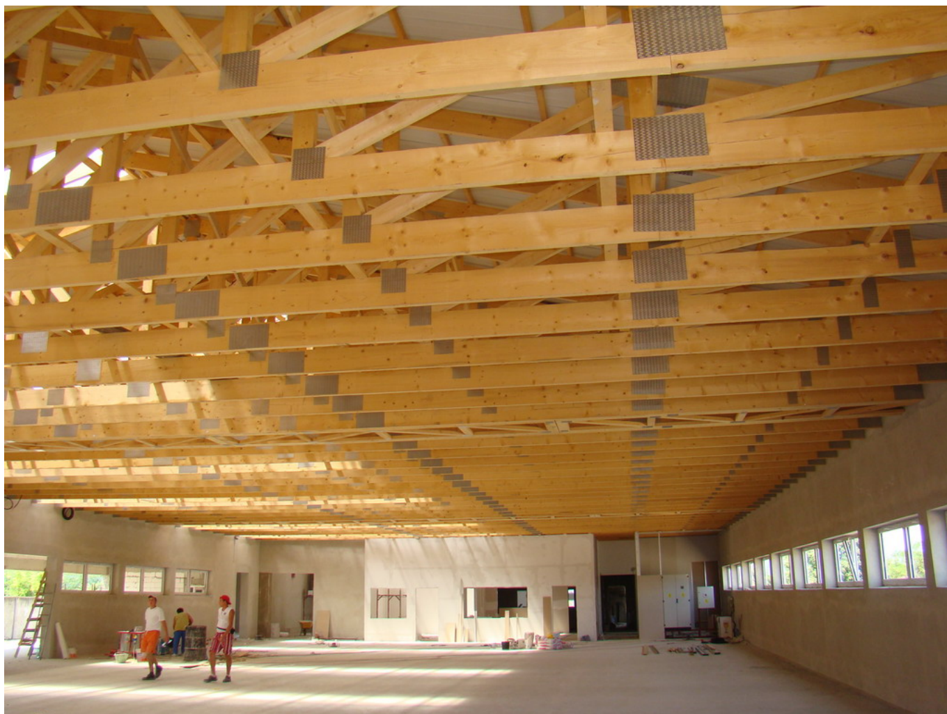
Hala din lemn Piatra Neamt
