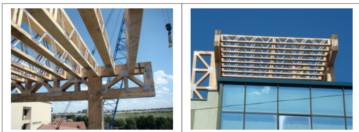
Tijele filetate, buloanele, suruburile de dulgherie sunt ajutate de placa multicii pentru ca saiba sa nu striveasca lemnul si pentru a nu ceda in timp.
