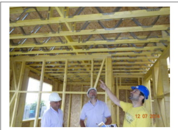
3. Placi multicii Posi Strut pentru planseu (inlocuieste placa de beton).
